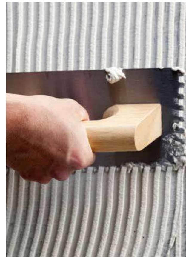
Adhesivo cementoso para la colocación de pavimentos interiores, exteriores y revestimientos interiores. Para el encolado de piezas cerámicas con grado de absorción medio-alto.
